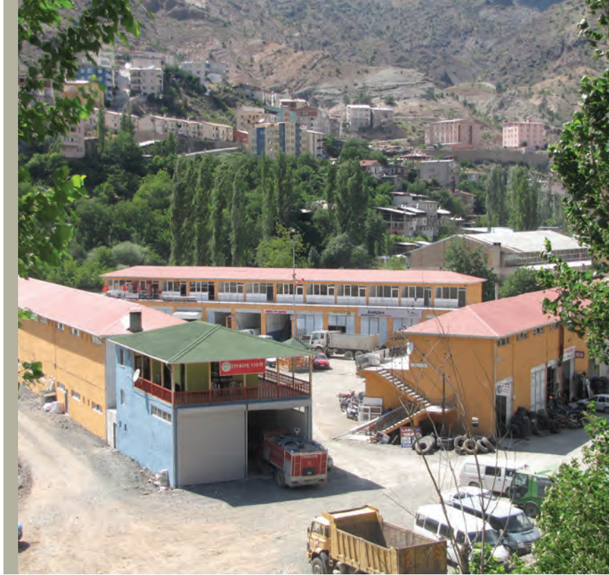
Yeni Sanayi Sitesinin inşaatı tamamlandı
