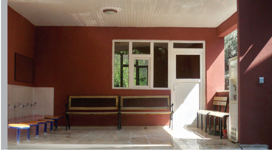
Evren mahallesi řadırvanı yenilendi
