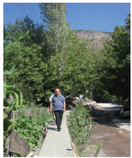
Hasanağa Mahallesinde dereiçi ve tüm ara yollar betonlandı.
